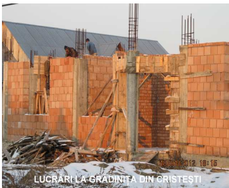
Grădinița în construcție
