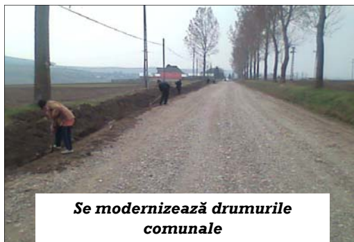
Se balastează DC 129 Cristești-Tătăruși
