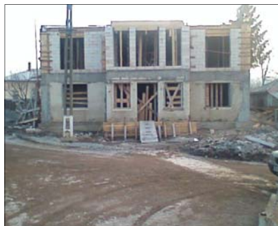
Clădirea Primăriei în construcție
